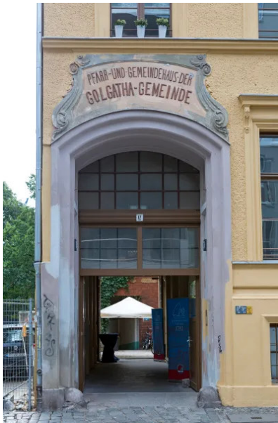
Eingang des Hauses. Foto: Yvonne Standke
