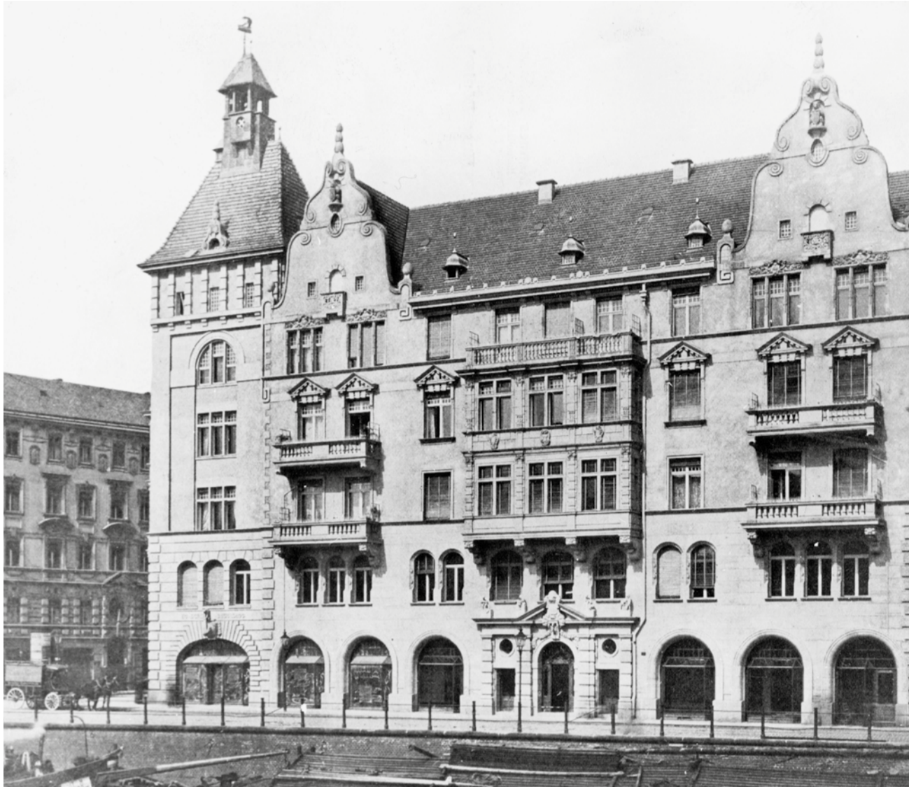
Das Gebäude Schiffbauerdamm 8, Ecke Albrechtstraße 13 kurz nach der Fertigstellung 1905 und heute (Foto unten)
